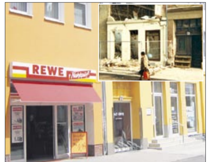
Nach gründlicher Sanierung eröffnete der REWE-Markt 1993 in der Bernauer Brüderstraße 10. Das obere Foto zeigt eine Ansicht während der Bauarbeiten Fotos: privat
